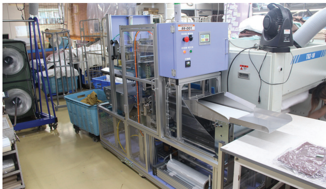
▲限られたスペースにレイアウトを工夫して設置
